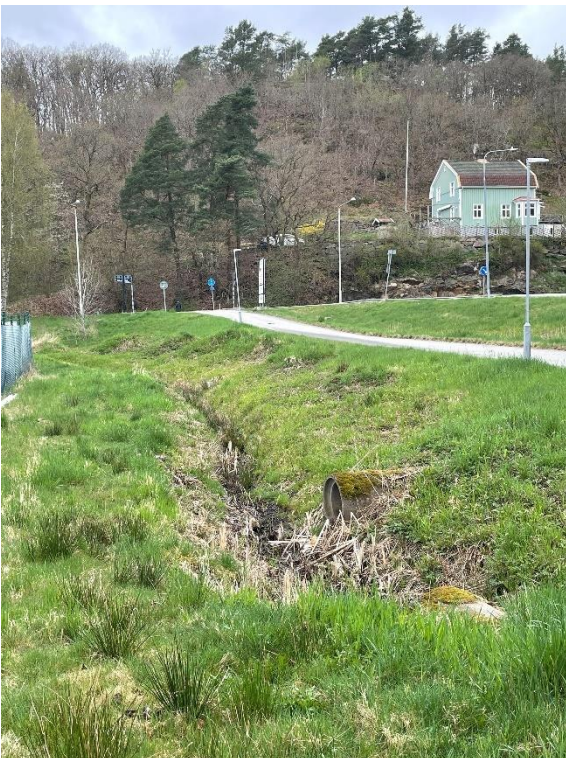
Figur 7. Bild 2 från platsbesök. Två befintliga trummor 500 mm respektive 800 mm som avvattnar befintliga diken under en väg (Utängarna) och vidare nedströms i riktning mot Kvällebacken.
