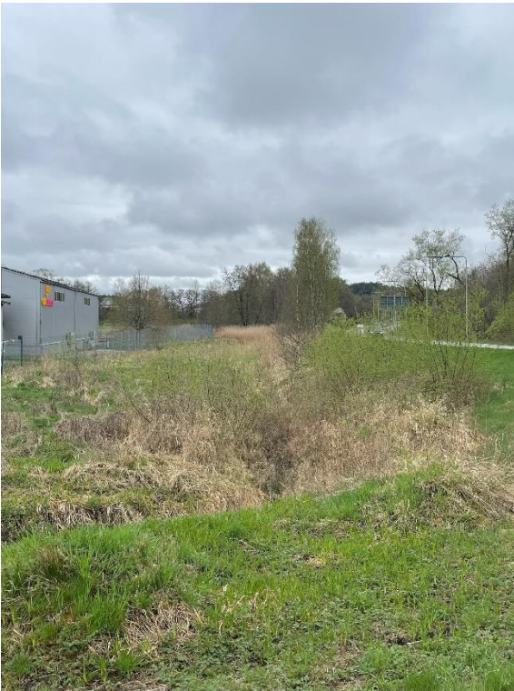
Figur 6. Bild 1 från platsbesök. Befintligt dike öster om Tuvevägen.
