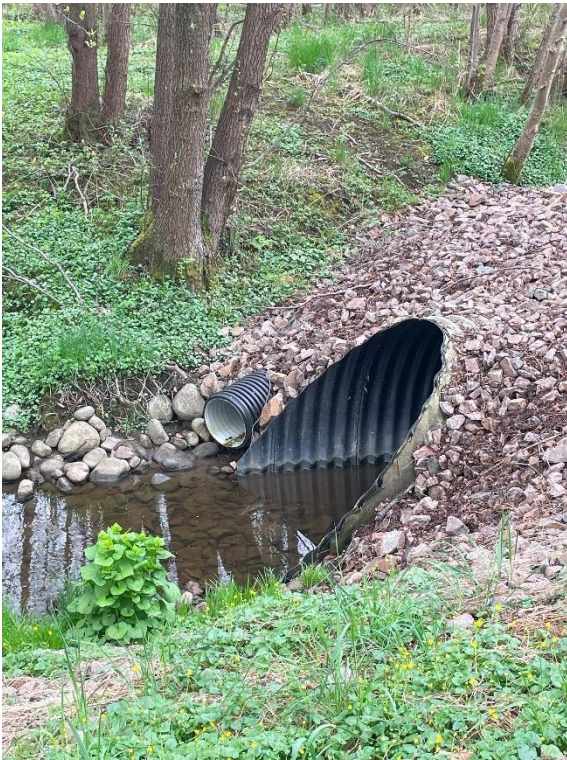
Figur 8. Bild 3 från platsbesök. Trumma som avvattnar Hinnebäcken under Tuvevägen söder om planområdet.
